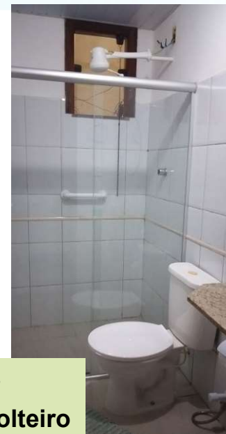
Banheiros c/ acessibilidade total e Barra de Proteção na área do Box
